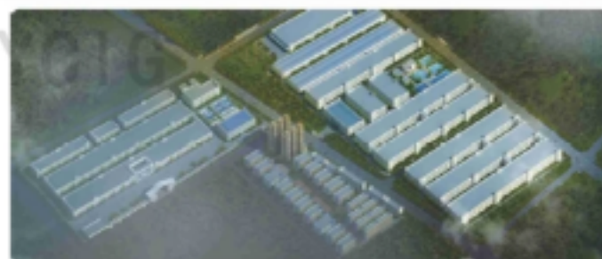
榔梨园区 建筑面积:108万m 2
